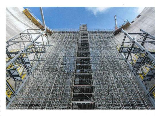
Einzelteilen, dazu kommt das niedrige Bauteilgewicht von maximal 18 kg, die schraubenlose Keilschlossverbindung und die günstige Materialausnutzung durch variable Feldlängen. So konnte Gerüstbau Rende das TG-60-System optimal an die vorhandenen Lasten und Bauwerksgeometrie anpassen. Dazu ließen sich alle Sonderlösungen wie Arbeitsebenen oder Treppentürme mit dem Standardzubehör aus dem Allround-Baukasten wirtschaftlich umsetzen.
